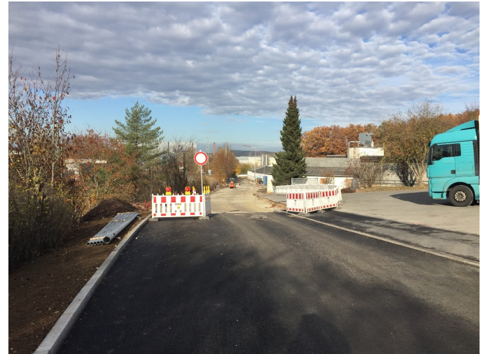
Bahnhofstraße / Birkleite - 3. Bauabschnitt in Bau
